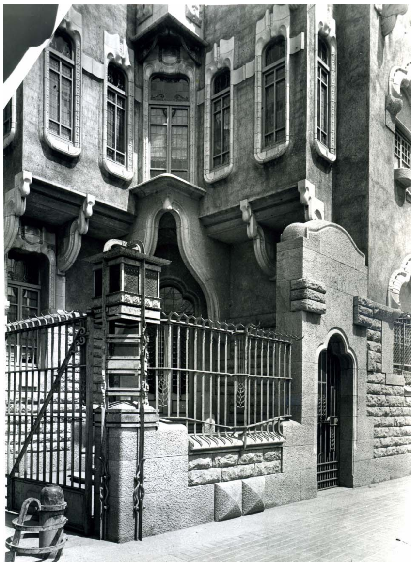
Entrada de la Farinera Teixidor, 1916 Fons de l'AHCOAC. © Arxiu Mas / Institut Amatller d'Art Hispànic
